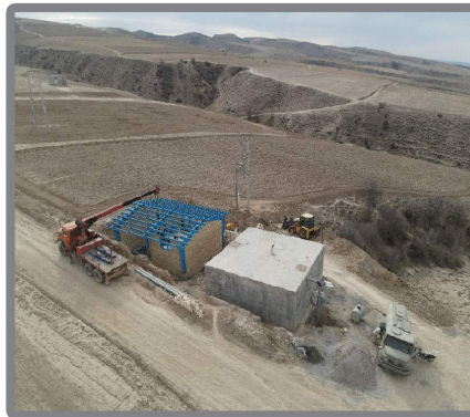
احداث ایستگاه پمپاژ مجتمع آبرسانی کهنه جلگه
